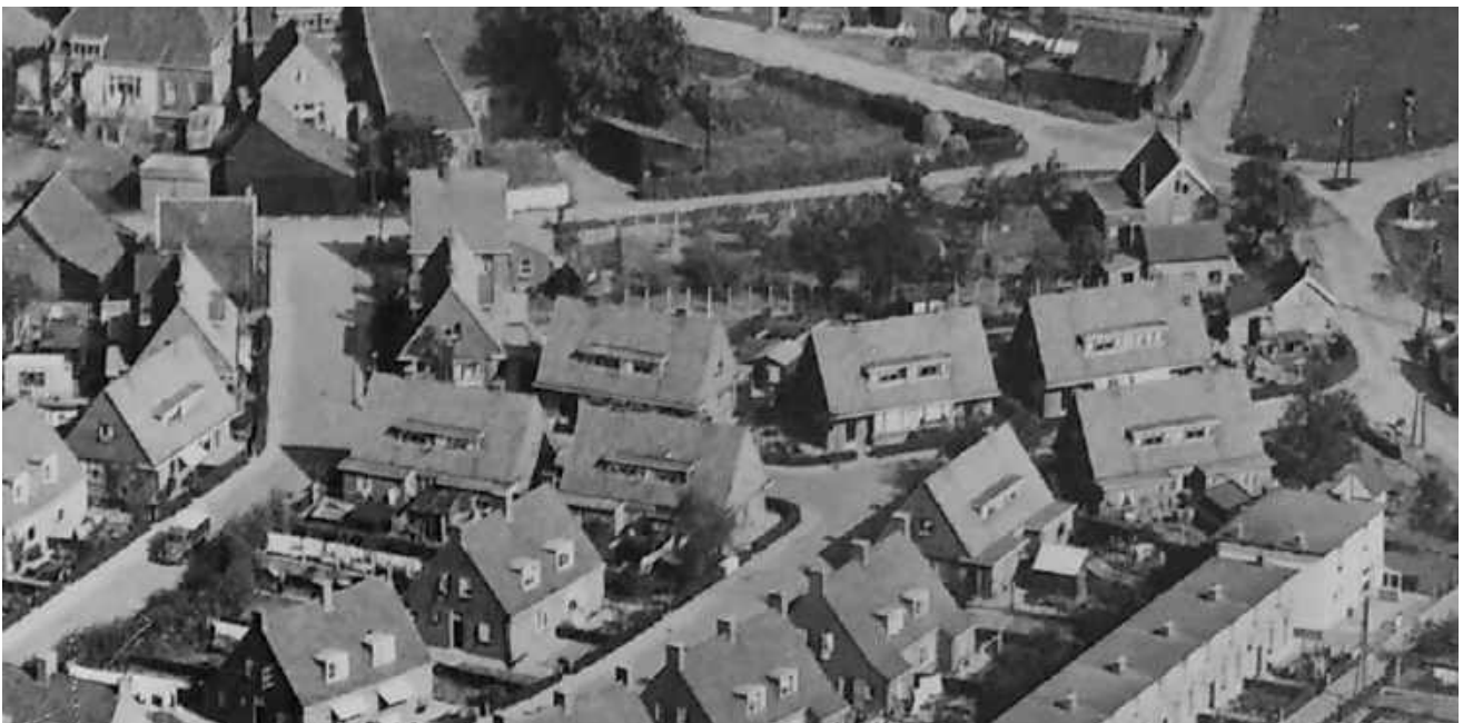
Foto 1. De huizen aan de Vermaatstraat hebben een aaneengesloten dakkapel, die aan de Eerste en Tweede Kooistraat hebben twee gescheiden dakkapellen. Rechtsonder de Nobelstraat.
