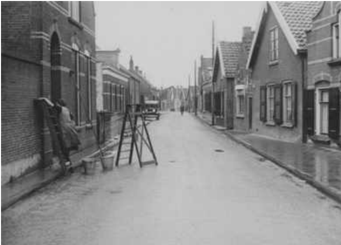
Foto 3. Noordeinde. Links het voormalige woonhuis van Jac. Hogenboom, en postkantoor, daarnaast woonhuis en schuur van Hogenboom.
